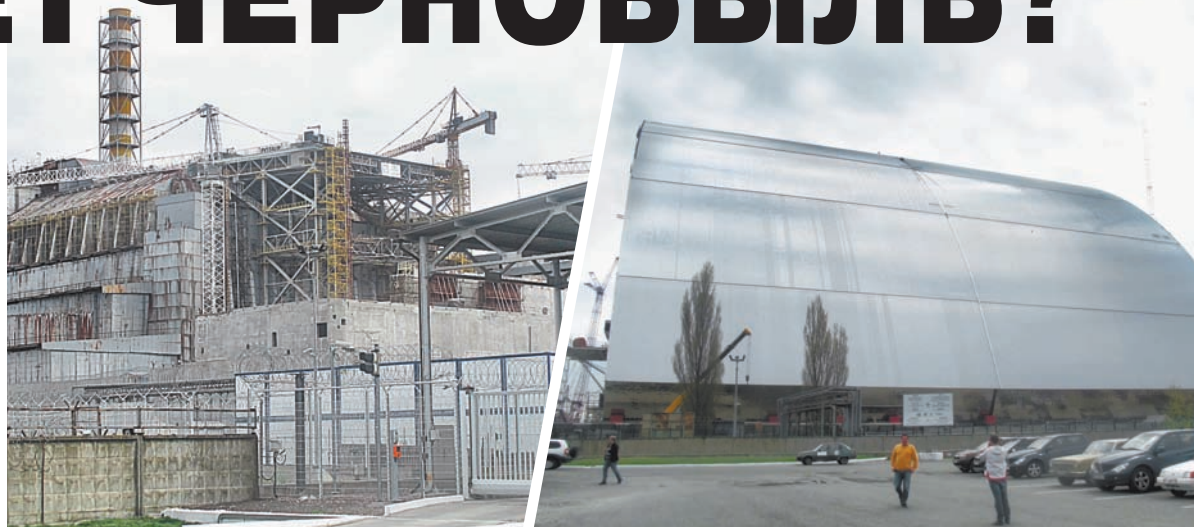
Новый саркофаг «Арка» (на фото справа) в 2018 г. накроет 4-й реактор, внутри которого по-прежнему тонны радиоактивных веществ.
