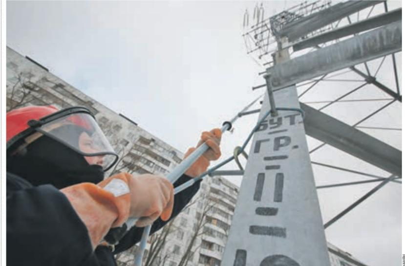
Вчера 08:00 Электромонтер 6-го разряда Станислав Волков проводит регламентные работы на опоре ЛЭП у дома №10 по Тимирязевской улице. Он проверяет, нет ли на этом участке утечки напряжения. Рутинная утренняя работа на самом деле крайне опасна, поэтому Станислав одет в специальный костюм, который сможет защитить от удара током.
