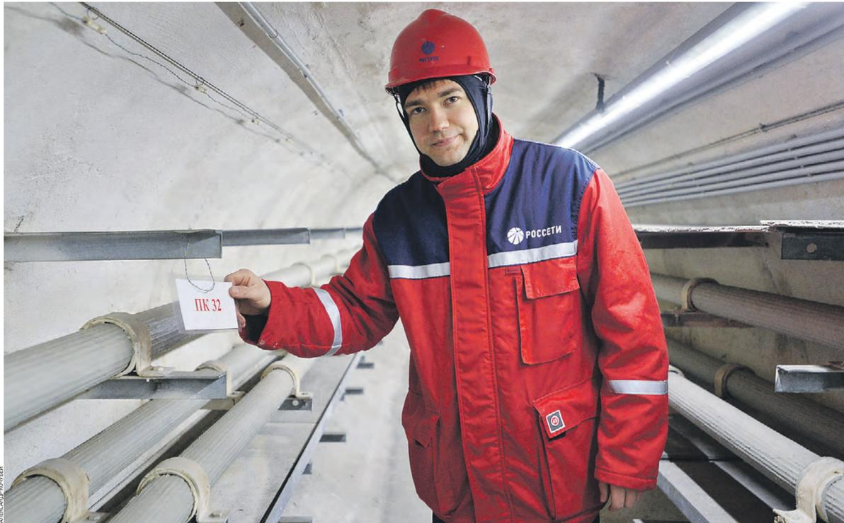
10 марта 10:30 Старший мастер цеха эксплуатационного обслуживания кабельных линий Егор Будылин проводит плановый осмотр Калитниковского коллектора, внимательно проверяя каждый сантиметр кабельных линий в подземном инженерном сооружении
